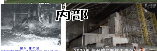
当初の「象の足」⇒ コンクリートで再補強
